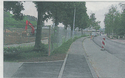
Dieser Teil der „Schwarzen Ern“ wird wieder frei gelegt. (FOTO: D. DIMMER)
