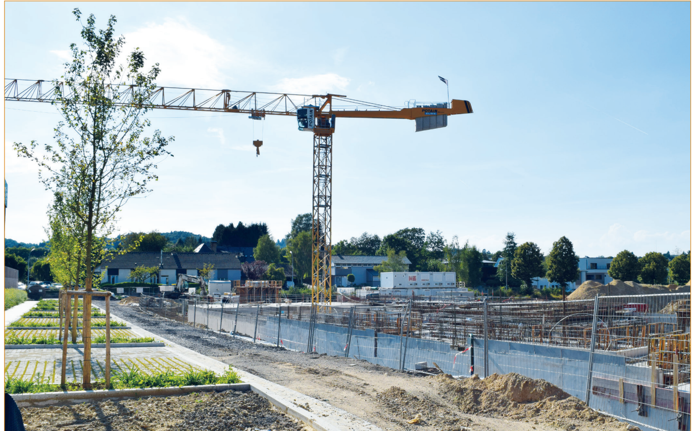
Baustellenfoto mit Blick auf Verbindungsstraße 'rue lernzwee'
