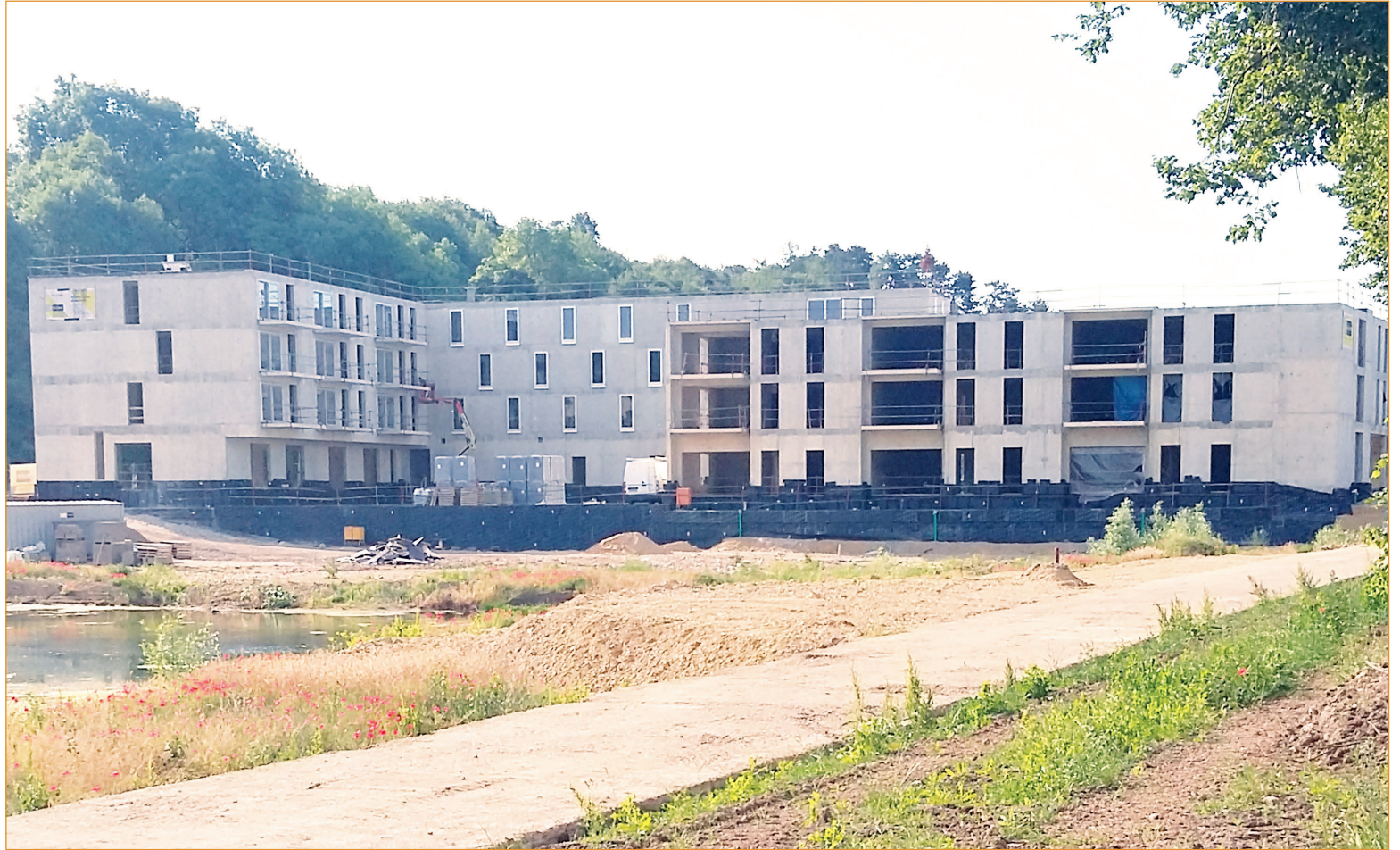
Foto Rohbau Mai 2017
