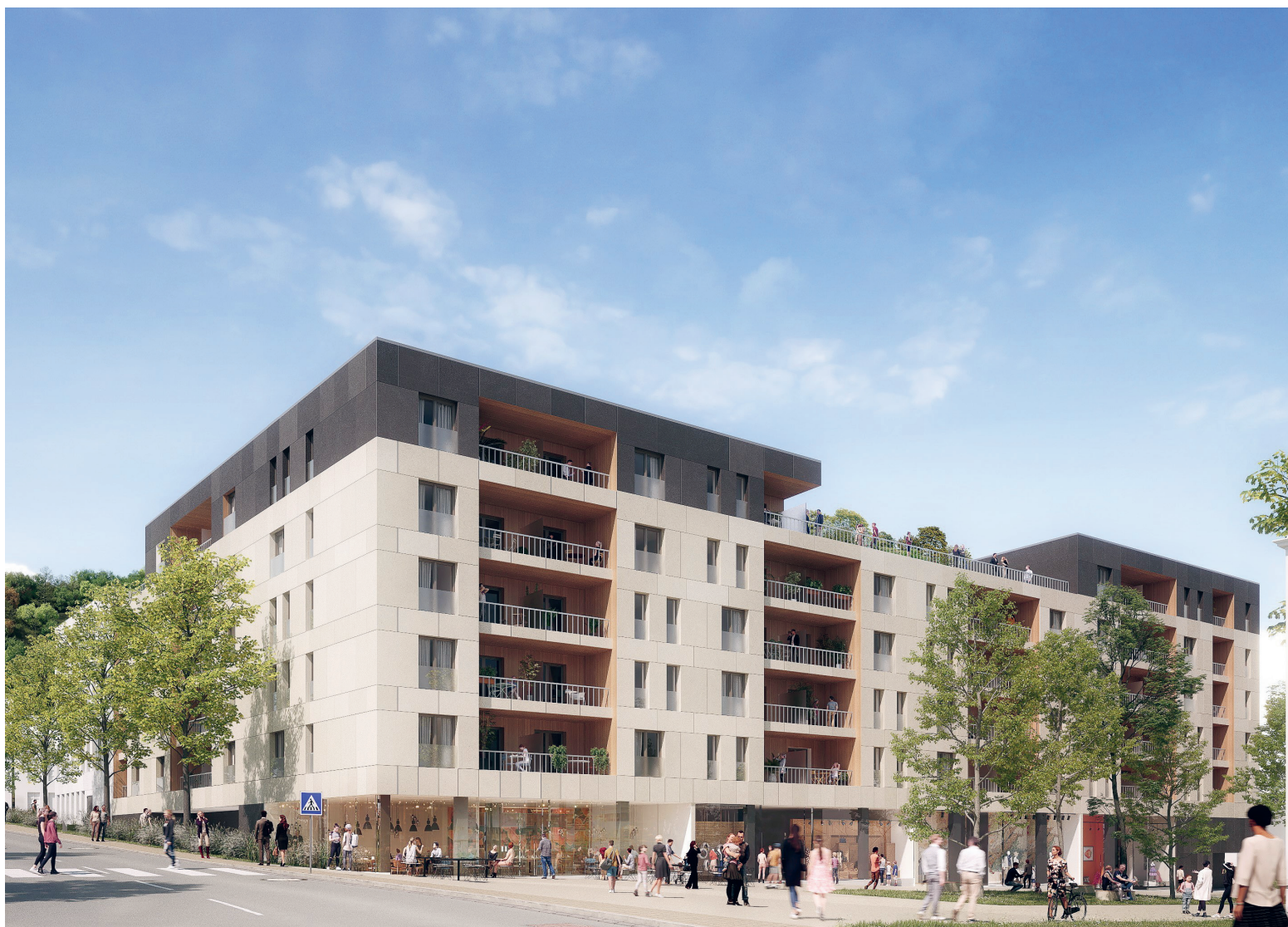
Plus de 190 millions d'euros sont dédiés à la reconversion de cet ancien ensemble ayant servi à l'armée.
